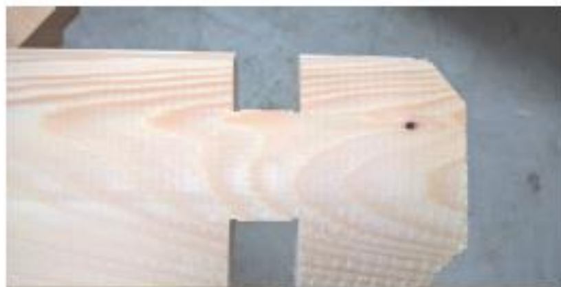
petits défauts d'usinage
